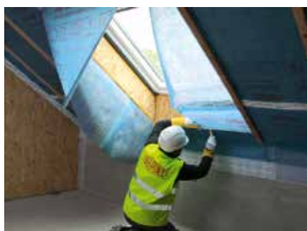
2. Uciąć pasmo równo z krawędzią dolnego ościeża okiennego ...
