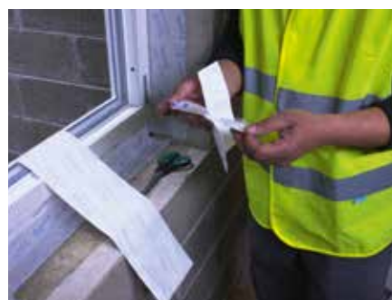
6. Usunąć ćwiartkę paska zabezpieczającego i ...
