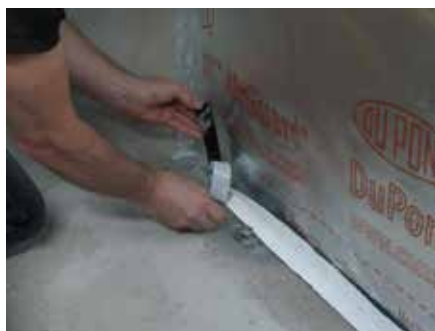
7. Ściągnąć spodnią folię zabezpieczającą od strony ściany i przykleić taśmą w żądanej pozycji. Usunąć resztę folii oddzielającej i od razu docisnąć taśmę klejącą do pasma na ścianie.
