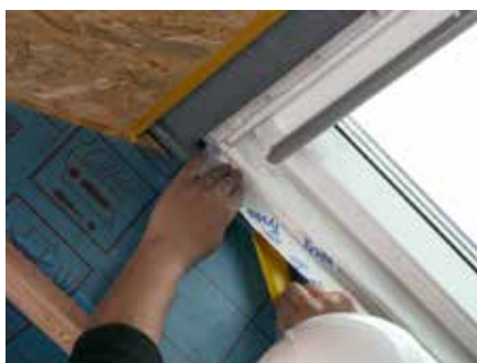
6. Połączyć odstaloną część taśmy klejącej z ościeżnicą okienną...
