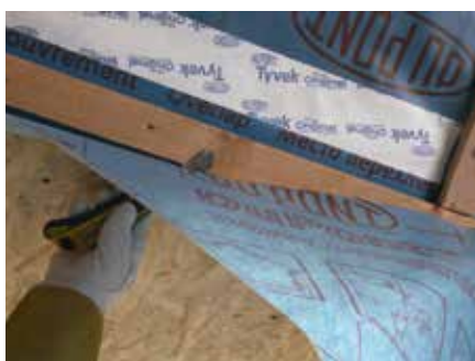
3. ... i krawędzią górnego ościeża okiennego.
