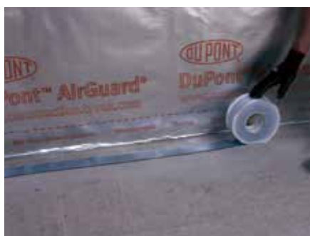
4. Zmierzyć i uciąć wymaganą długość elastycznej taśmy Tyvek® FlexWrap EZ.
