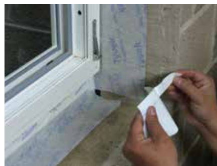
9. Usunąć folię zabezpieczającą.
