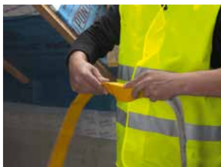
5. Zastosować taśmę klejącą Tyvek® 60 mm z dzieloną folią zabezpieczającą, złożyć najpierw taśmę wzdłuż na podziałe i ściągnąć wąską część folii zabezpieczającej.
