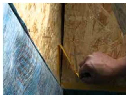
4. Usunąć folię zabezpieczającą dwustronnej taśmy klejącej Tyvek® 20 mm i docisnąć resztę paroizolacji AirGuard® do drewnianej konstrukcji. Odciąć nadmiar materiału.
